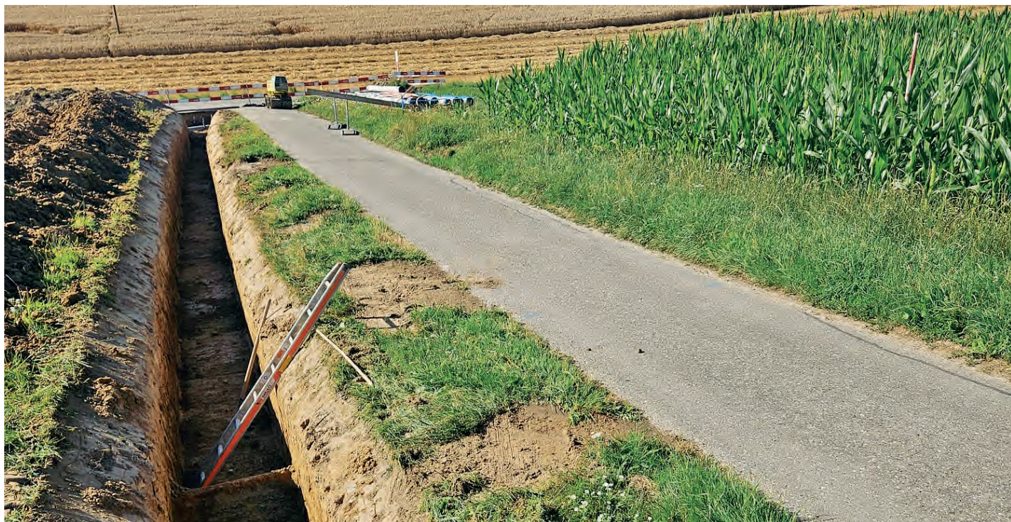
Anschlussgraben Bollstrasse Hessigkofen
