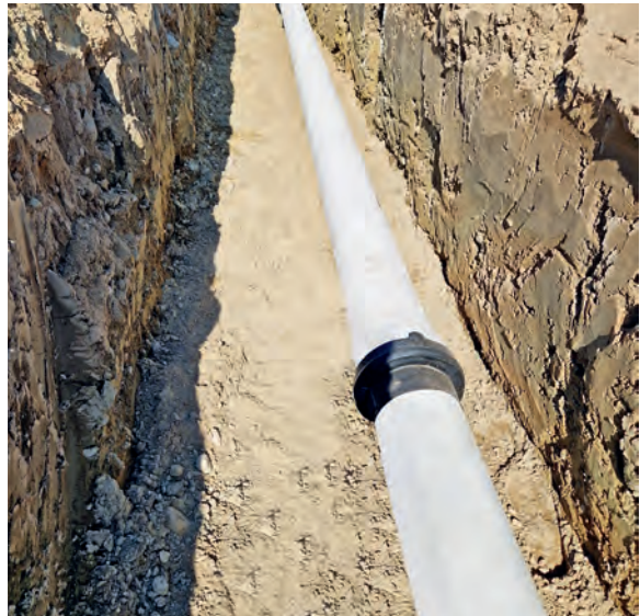
Bau im offenen Graben
