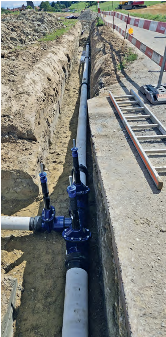
Abgang Hessigkofen Richtung Bollstrasse
